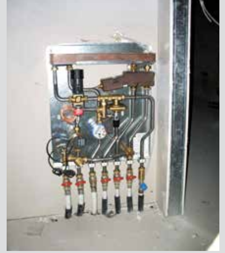
Daire istasyonunun duvara montajı.
