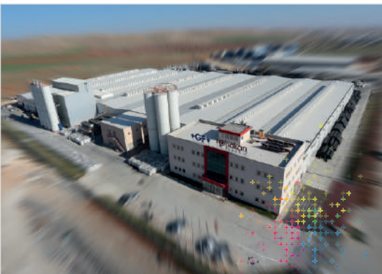
Georg Fischer Hakan Plastik Şanlıurfa Üretim Tesisleri
