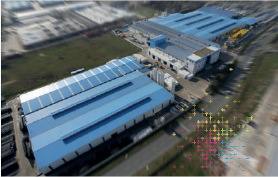
Georg Fischer Hakan Plastik Çerkezköy Üretim Tesisleri
